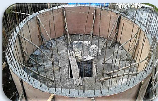
Bekisting van de opslagtank in Siling bijna af.
